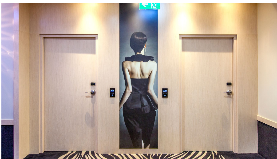
drzwi przeciwpożarowe FR EI30, ościeżnica stała drewniana
