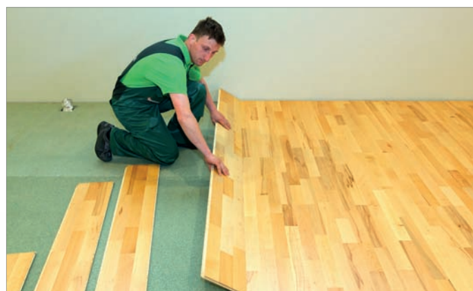
Zdjęcie 22. Do deski startowej dokładamy pas desek z lewej i prawej strony. Robimy to w sposób symetryczny. Łączymy deski na zamkach wzdłużnych i dobijamy je drewnianym dobijakiem. Podobnie postępujemy przy połączeniu desek na krótszych czołach. W celu zlicowania połączenia desek dobijamy je na krótszej krawędzi.
