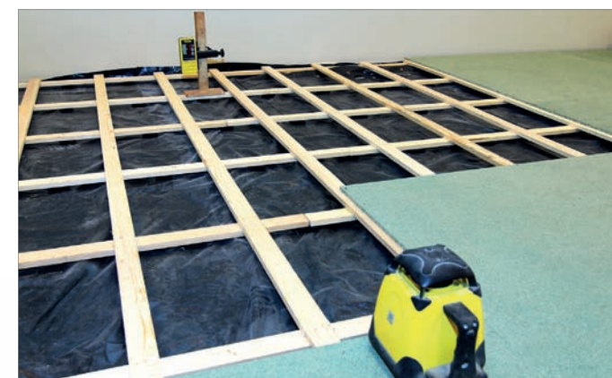
Zdjęcie 14. Należy pamiętać o wentylacji mechanicznej przy powierzchniach podłogi powyżej 400 \text{ m}^2 . Na tak przygotowany ruszt możemy układać płyty OSB lub P5. W trakcie montażu płyt wykonujemy pomiary płaszczyzny rusztu, a ewentualne odchyłki niwelujemy za pomocą drewnianych podkładek dystansowych.
