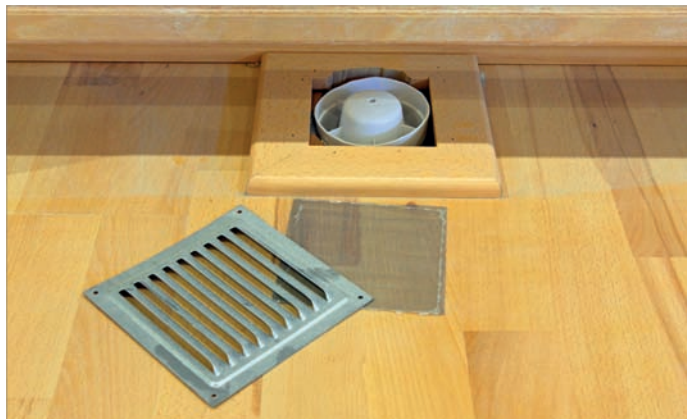
Zdjęcie 25. Wszystkie wentylatory obudowywane są listwami i zabezpieczone ażurową kratką metalową.
