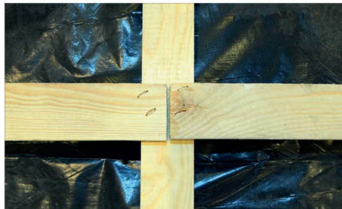
Zdjęcie 10. Połączenia wzdlużne legarów warstwy górnej wykonujemy za pomocą zszywek. Pomiedzy czołami legarów zostawiamy szczelinę 2 - 3 mm i każdy legar łączymy mechanicznie za pomocą dwóch zszywek.
