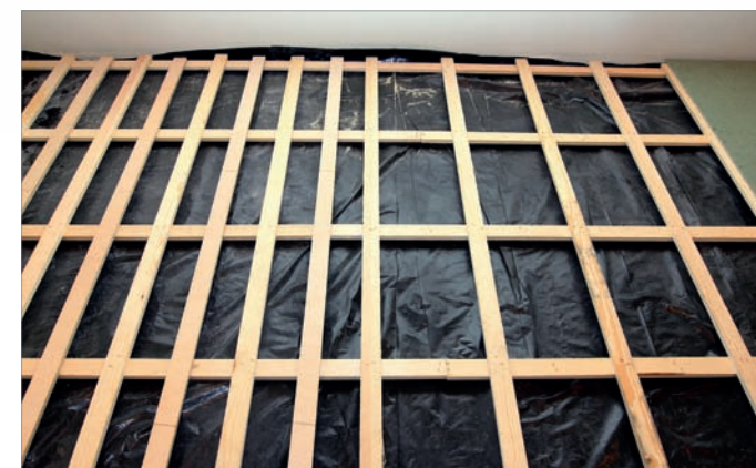
Zdjęcie 13. W miejscach, gdzie będą stały trybuny dla widowni oraz ławki ruszt należy zagęścić zgodnie z wytycznymi projektu.
