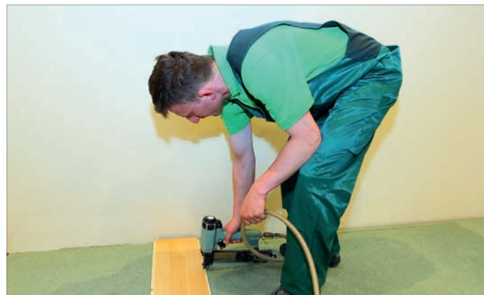
Zdjęcie 20. Zszywki mocują wpust deski do płyty w rozstawie co 300 mm. Po zamontowaniu całego pasa deski startowej rozpoczynamy montaż podłogi sportowej.
