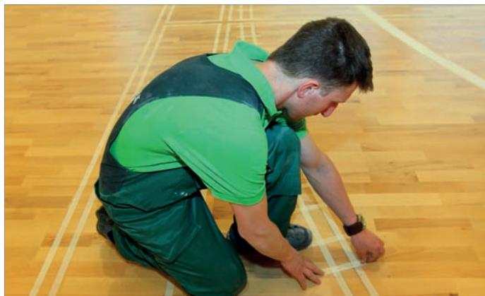
Zdjęcie 26. Kolejnym etapem jest malowanie linii na podłodze specjalnymi farbami. Po wytrasowaniu zgodnie z projektem i zaznaczeniu linii kontury obklejamy samoprzylepną taśmą papierową.
