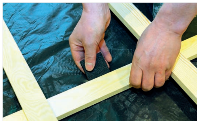
Zdjęcie 11. Pod tak przygotowaną konstrukcję krzyżową musimy podłożyć podkładki elastyczne. Podkładki o wymiarach 18 mm x 50 mm x 50 mm wykonane są ze sztucznego tworzywa o współczynniku sprężystości przy ściskaniu E_c = 2,85 \text{ N/mm}^2 oraz gęstości 725 \text{ kg/m}^3 . Podkładki elastyczne podkładamy pod dolny legar w połowie rozstawu pomiędzy połączeniami z legarami warstwy górnej.
