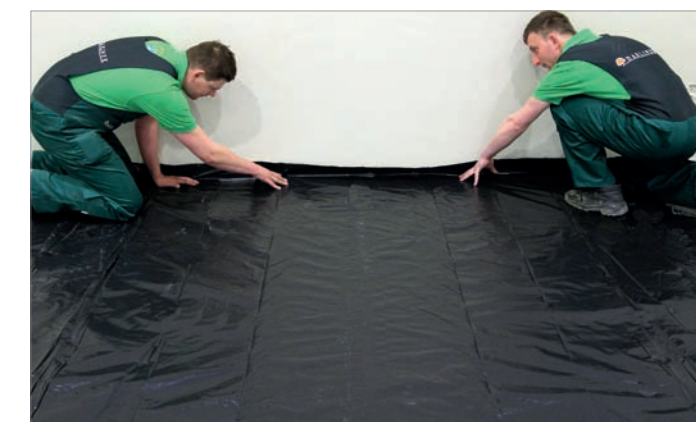
ZDJĘCIE 4. IZOLACJA PRZECIWWILGOCIOWA – ISTOTNE JEST, ABY POMIĘDZY ŚCIANĄ A PODŁOGĄ POZOSTAWIĆ ODPOWIEDNIO DUŻY ZAPAS FOLII.
